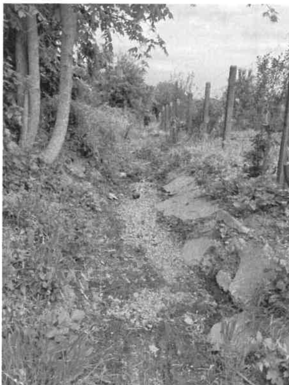
12. kép: 3. helyszín, 376 hrsz, tönkrement betonburkolat és lerakódott hordalék a beton burkolat vége, földárok a folytatásban
