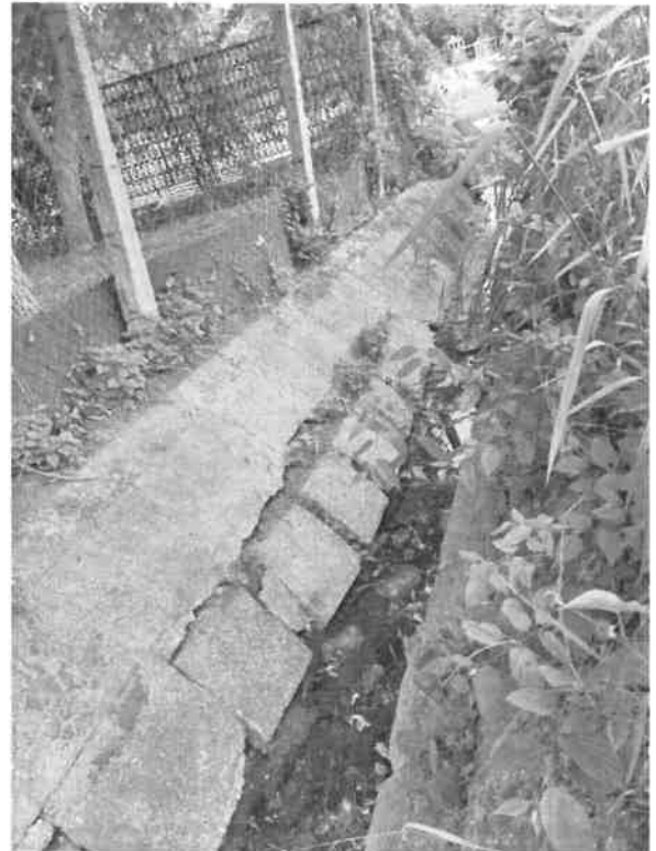
4.-5. kép: 1. helyszín: 559 hrsz, tönkrement lapburkolat
