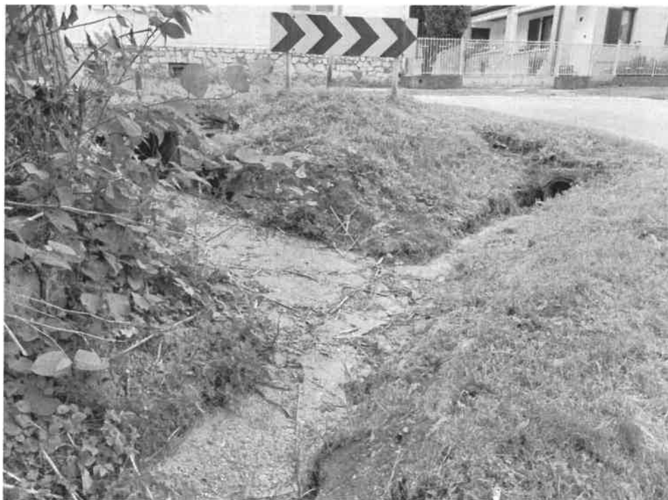
7. kép: 2. helyszín, 193/4 hrsz, tönkrement lapburkolat
