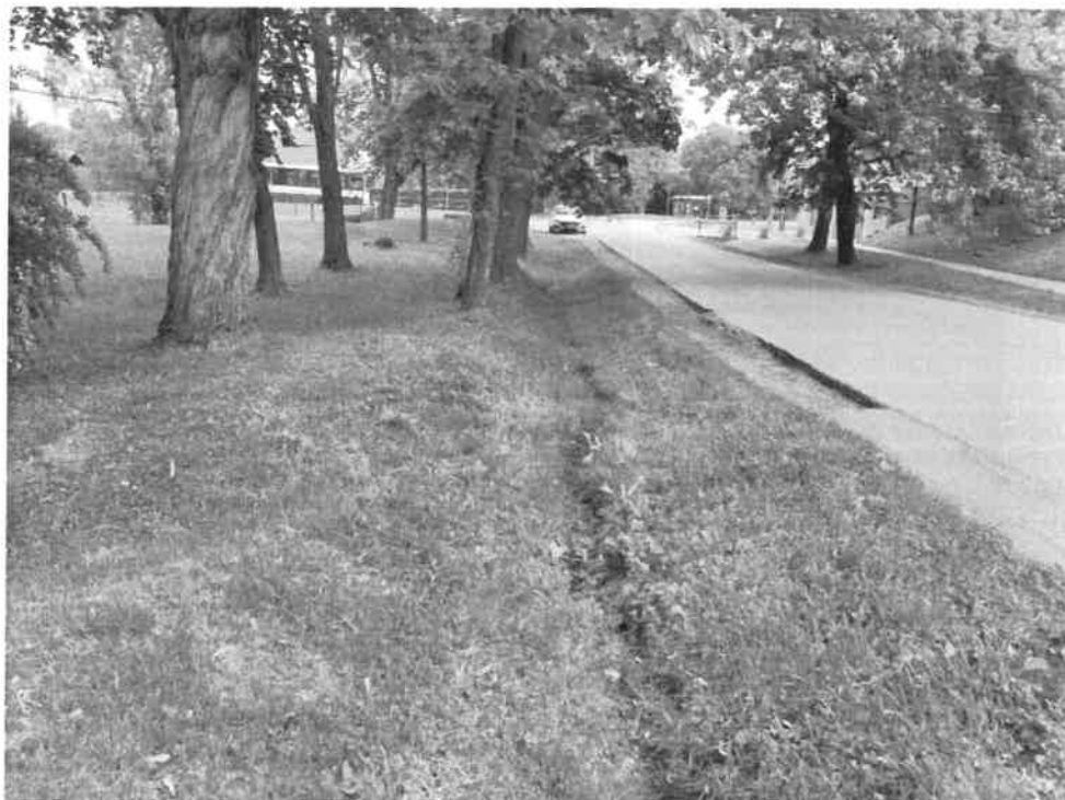
16. kép: 5. helyszín, 1384 hrsz, tönkrement, feliszapolódott földárok
