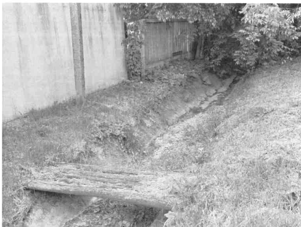
10. kép: 3. helyszín, 376 hrsz, tönkrement betonburkolat és lerakódott hordalék
