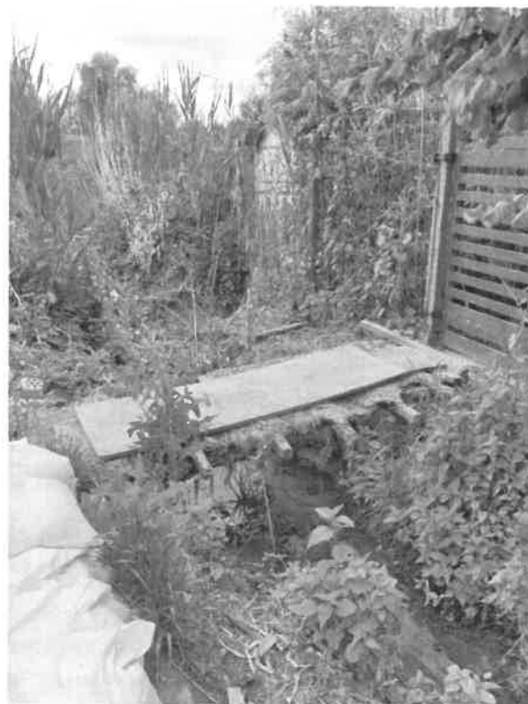
13.-14. kép: 4. helyszín, 268 hrsz, tönkrement földárok és lerakódott hordalék
