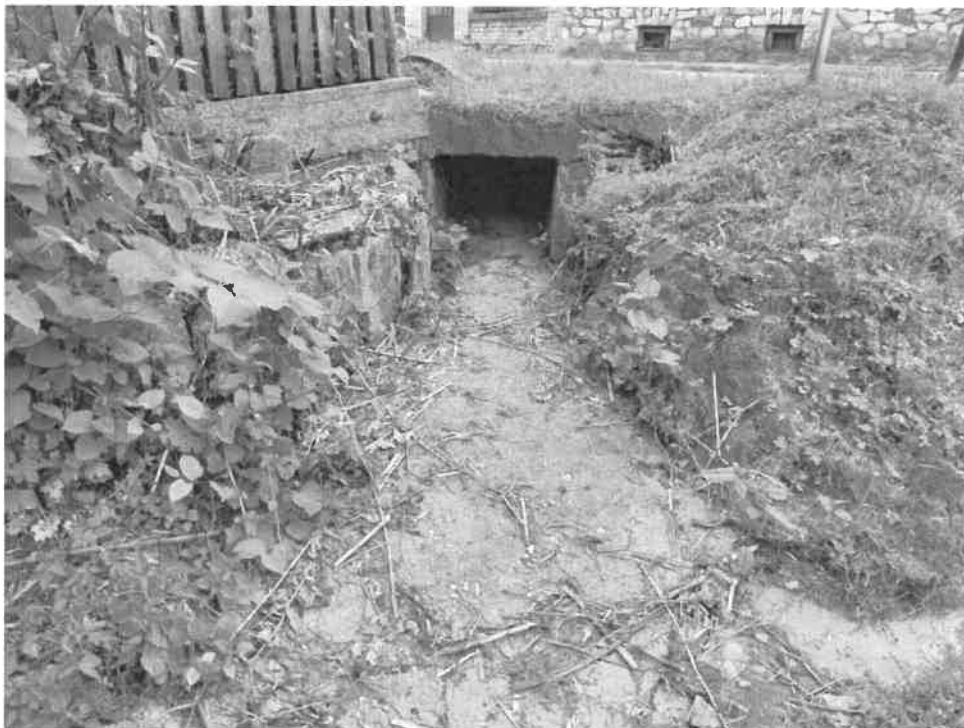
9. kép: 2. helyszín, 193/4 hrsz, tönkrement beton és kőburkolat
