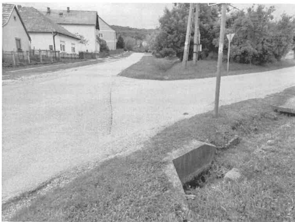
18. kép: 5. helyszín, 1384 hrsz, tönkrement áteresztetőelőfej a Béke utca burkolat csatlakozása alatt
