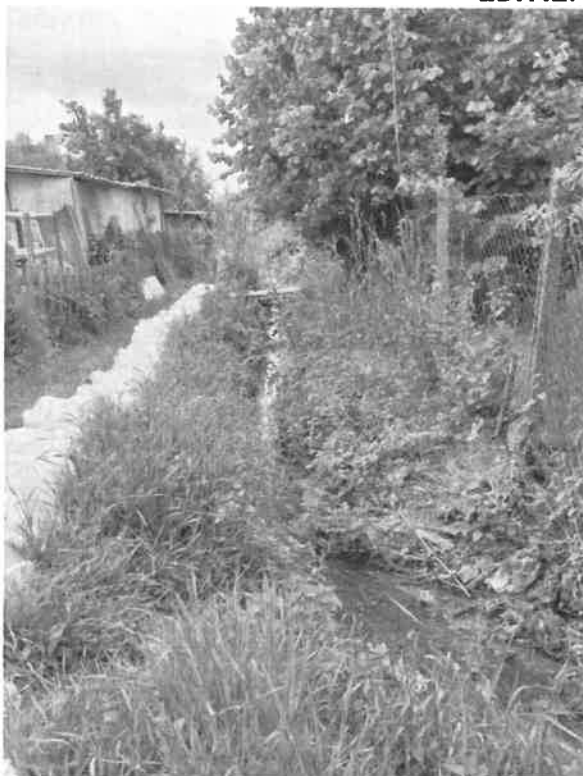
13.-14. kép: 4. helyszín, 268 hrsz, tönkrement földárok és lerakódott hordalék
