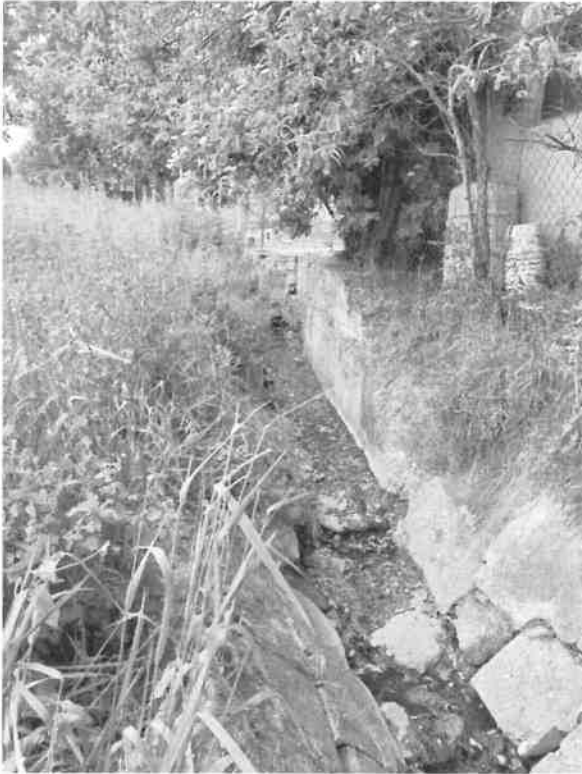
4.-5. kép: 1. helyszín: 559 hrsz, tönkrement lapburkolat
