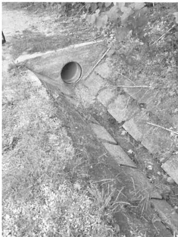
6. kép: 2. helyszín, 193/4 hrsz, tönkrement lapburkolat
