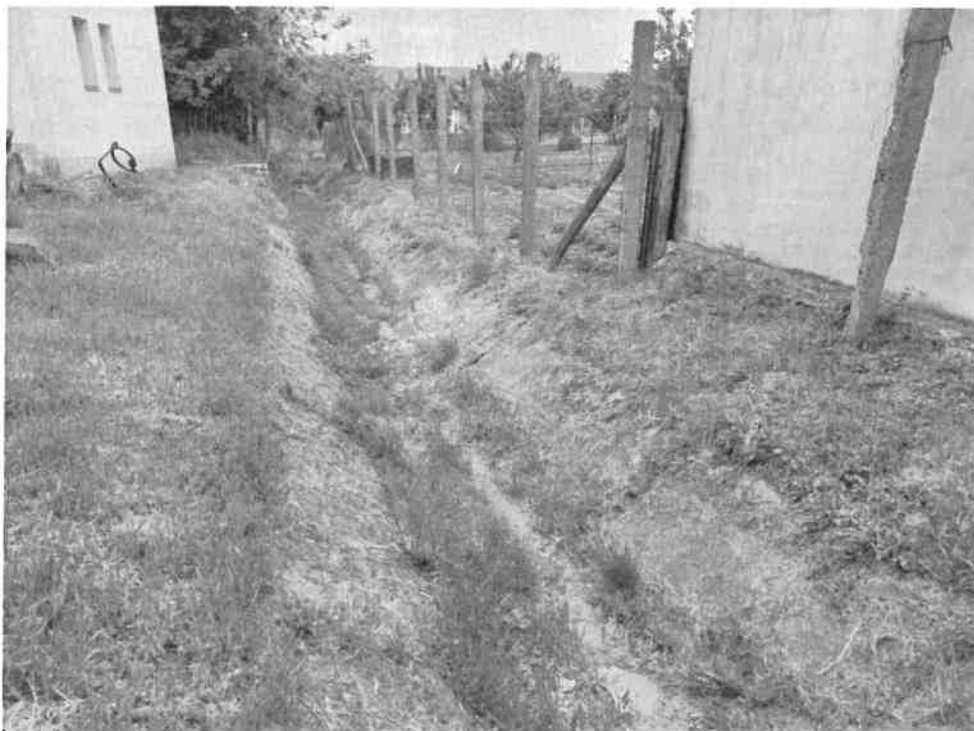
11. kép: 3. helyszín, 376 hrsz, tönkrement betonburkolat és lerakódott hordalék
