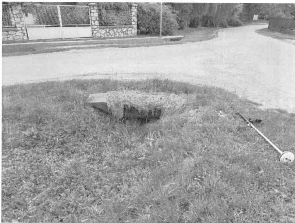
18. kép: 5. helyszín, 1384 hrsz, tönkrement áteresztetőelőfej a Béke utca burkolat csatlakozása alatt
