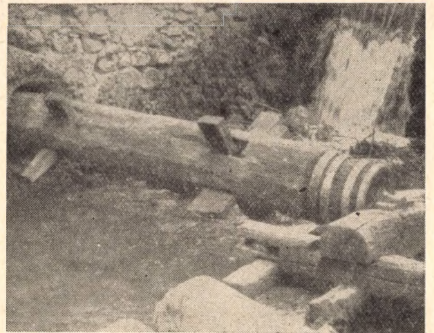
4. kép. A felülsapott vízikerek tengelymaradványa a zuhogónál
